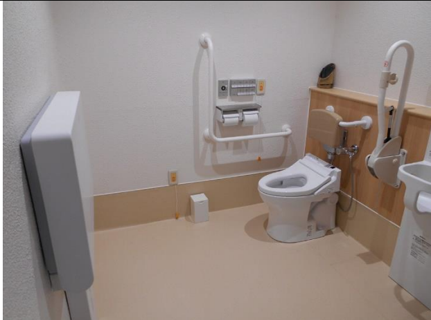
バリアフリートイレには、ベビーキープ、おむつ交換台がある。
